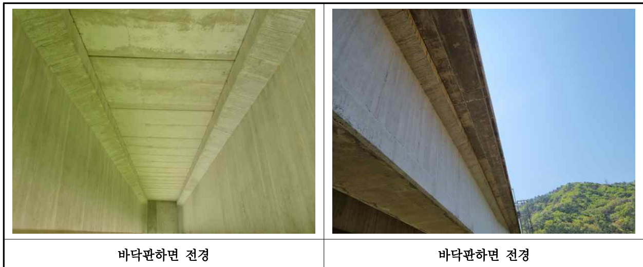
【사진 27.3.2】 바닥판하면 전경
