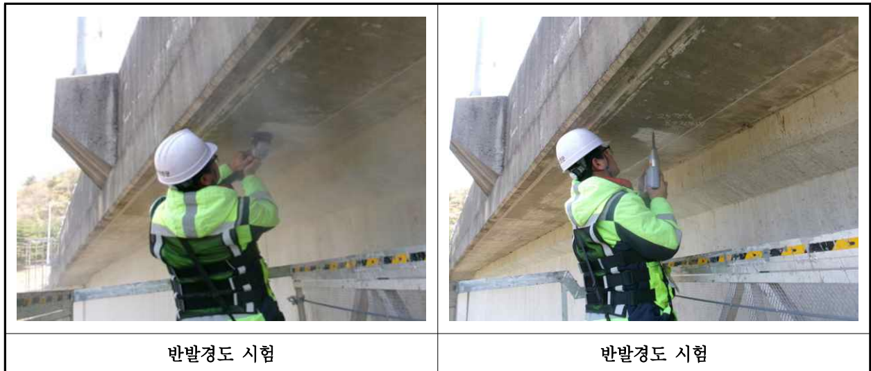
【사진 27.4.2】 반발경도시험 현장사진
