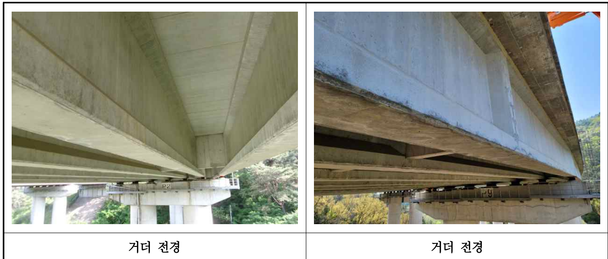
【사진 27.3.4】 거더 전경
