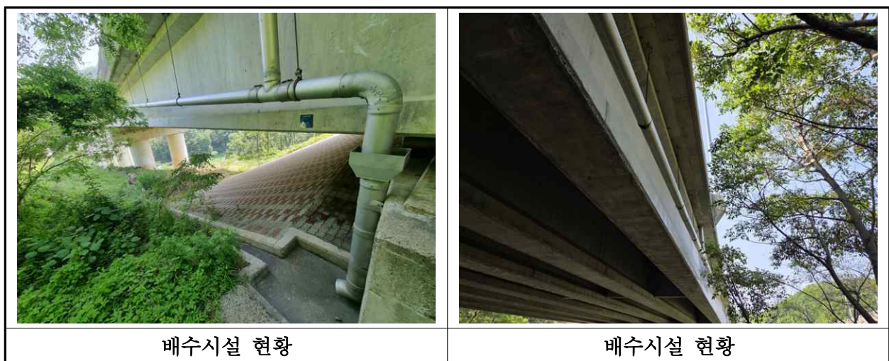
【사진 27.3.22】 배수시설 전경
