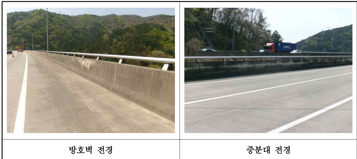
【사진 27.3.24】 방호벽 및 중분대 전경
