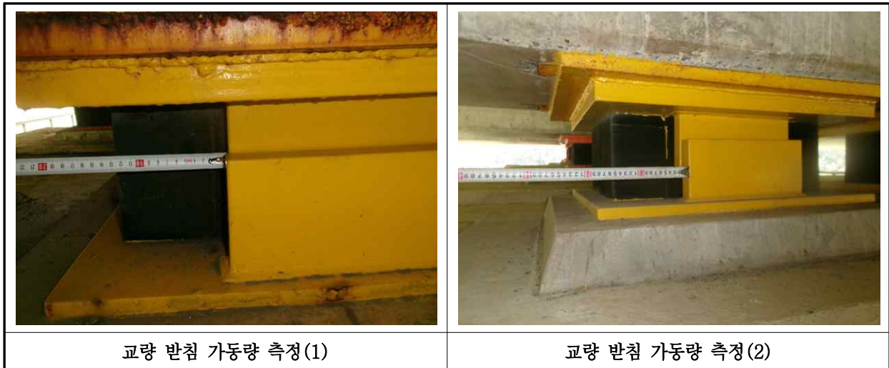
【사진 27.3.16】 교량받침 이동량 측정
