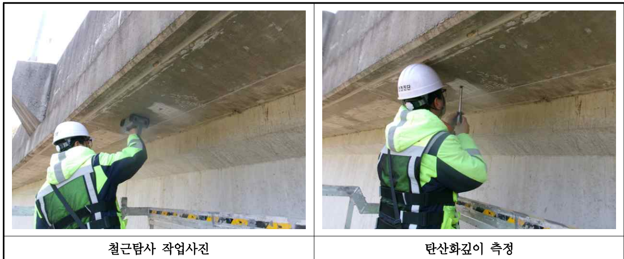
【사진 27.4.3】 탄산화 깊이 측정 현장사진
