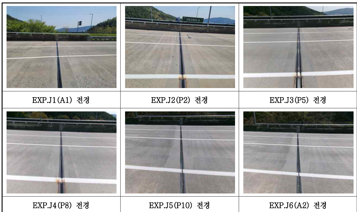
【사진 27.3.17】 신축이음장치 전경
