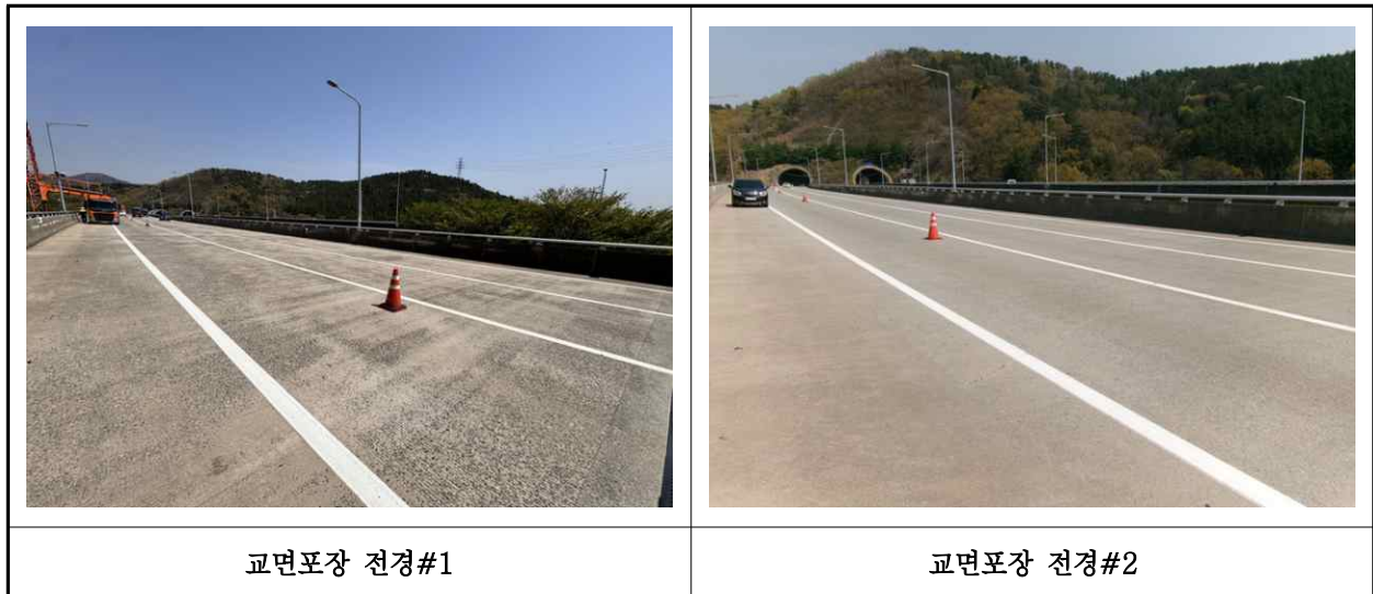
【사진 27.3.20】 교면포장 전경
