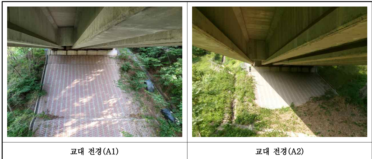
【사진 27.3.8】 교대 전경
