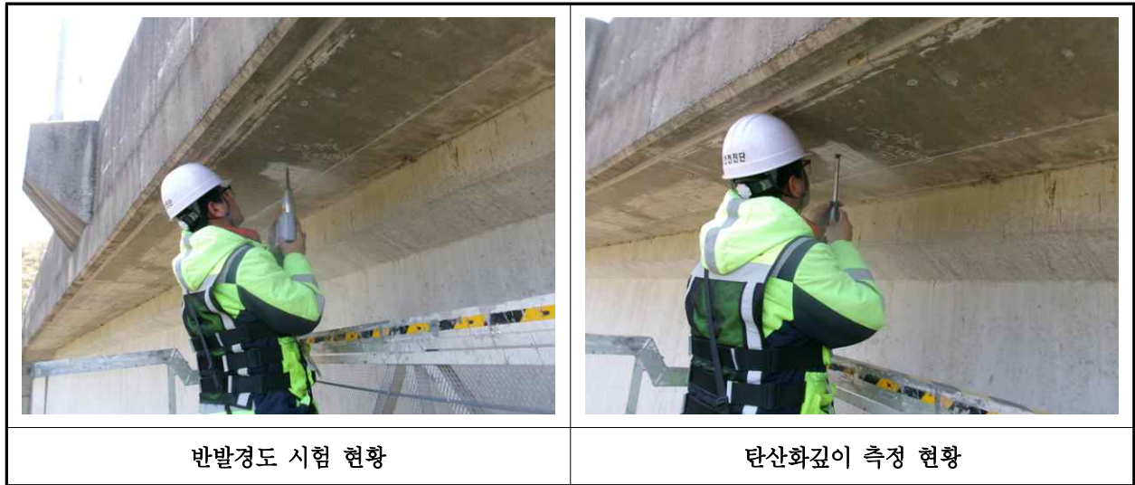
【사진 27.4.1】 콘크리트 내구성조사 현황
