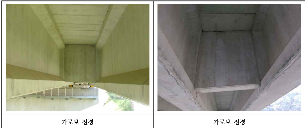
【사진 27.3.6】 가로보 전경
